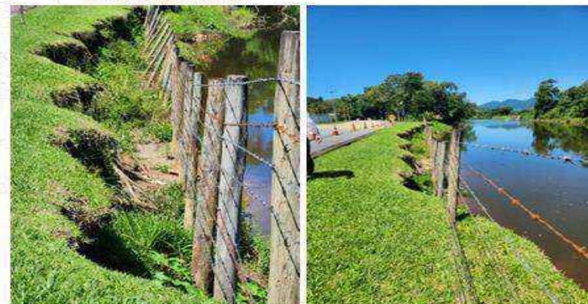
21 - Talude em condomínio
