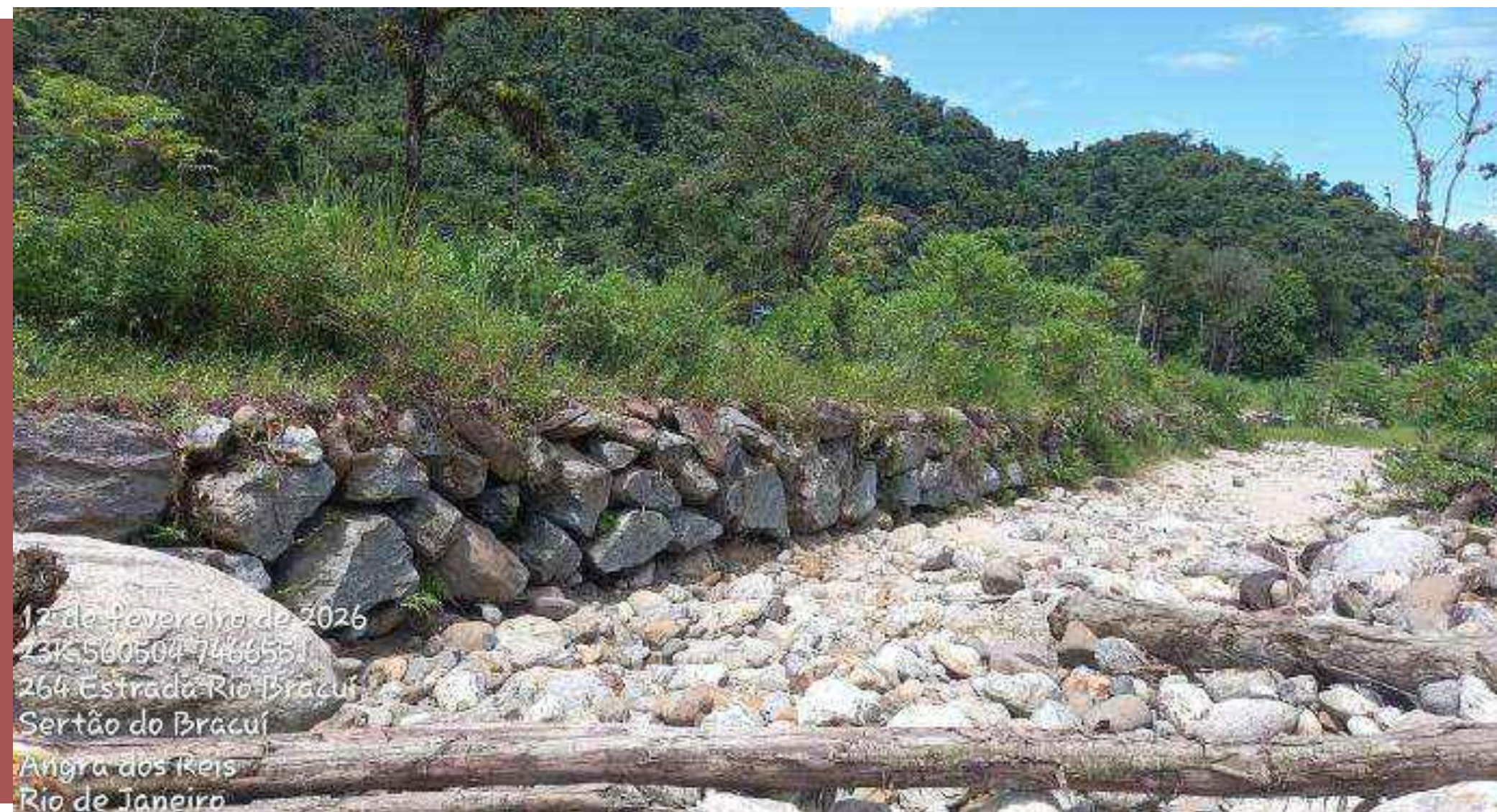
Trecho do canal a ser desobstruído.
