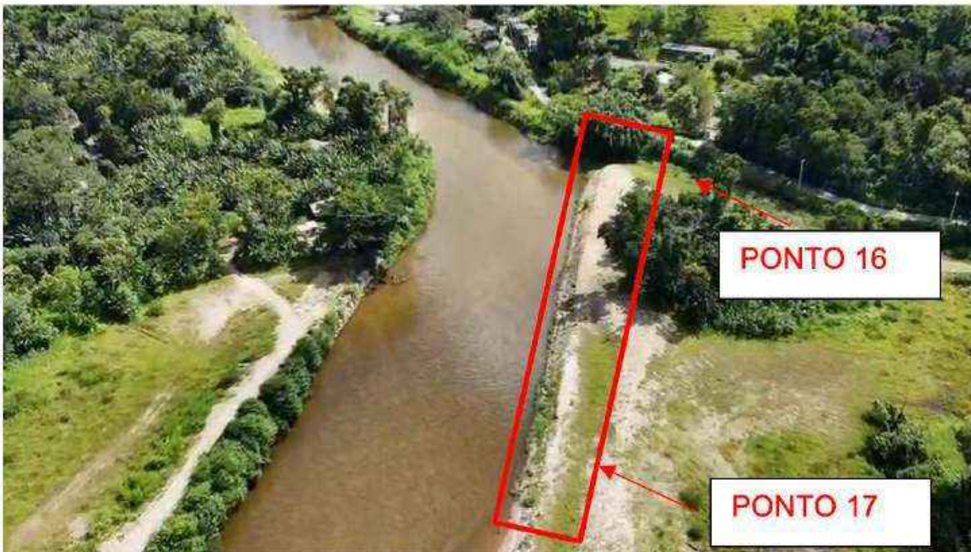
Revegetação e contenção de danos no talude existente.
