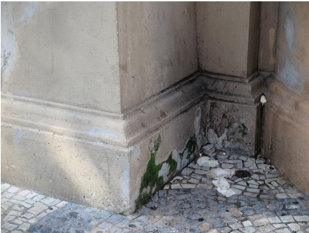
Foto 20: Danos Gerais levantados: Trincas e perda de argamassa.
