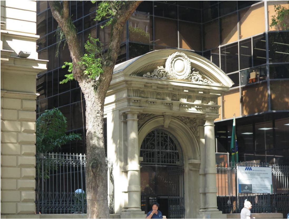
Foto 3: Vista do pórtico da esquerda do protão e do gradil (Junto ao prédio da Seção Judiciária do Rio de Janeiro)
