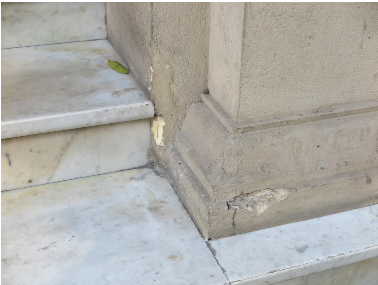
Foto 20: Danos Gerais levantados: Trincas e perda de argamassa.
